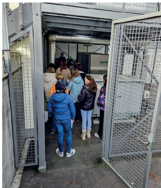
Besichtigung des Wärmetauschers.
